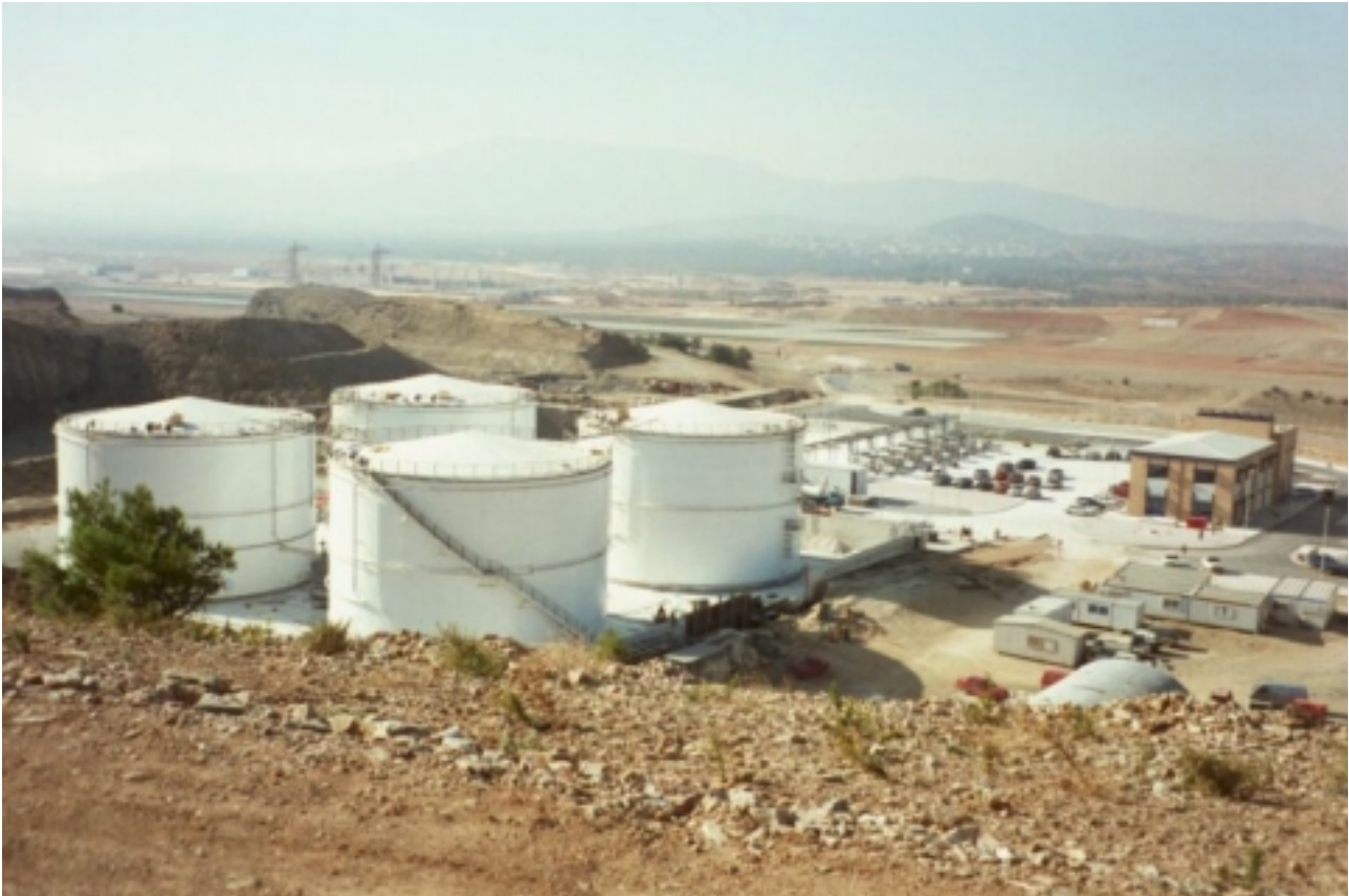
Bild 4: Tankfarm in Richtung Airport, im Hintergrund die östliche Piste
