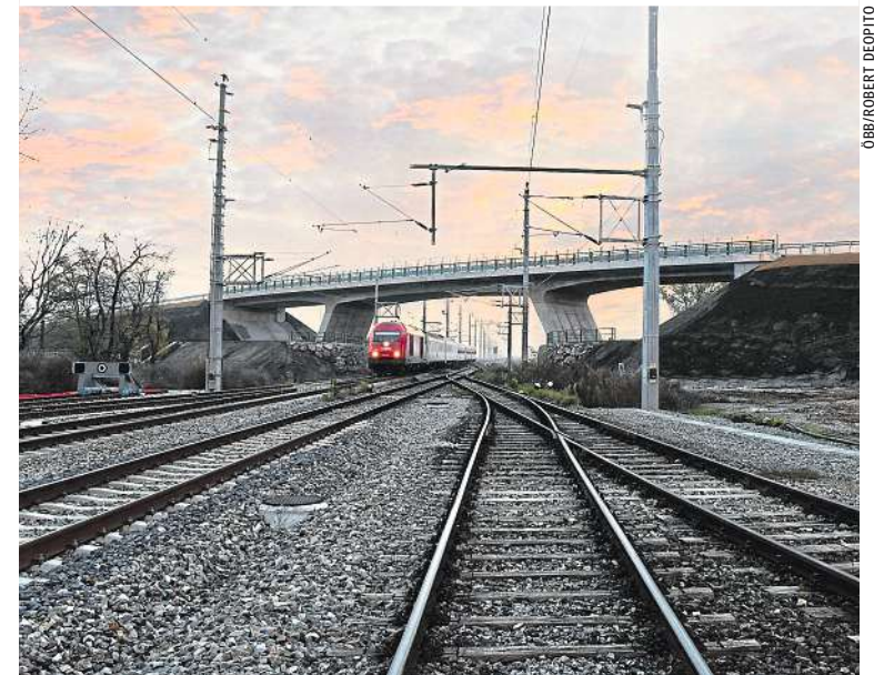
Die Bahnverbindung Wien-Bratislava im Marchfeld wird zweigleisig ausgebaut
