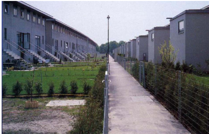
Abb. 8: Beispiel einiger Reihenhäusern mit dazwischenliegenden Fußwegen 1
